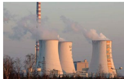
Elektrownia Jaworzno, Polska
