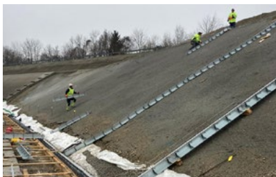
Elektrownia Töging-Jettenbach, Niemcy
